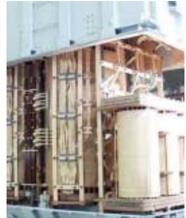
Montaje de transformador de gran potencia
