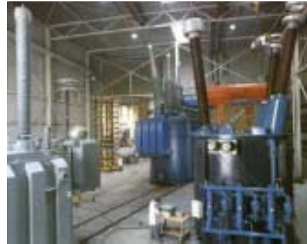
Vista de nave de ensayos
