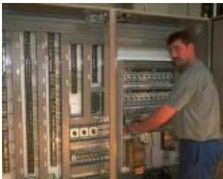
Ensayo funcional del circuito secundario
