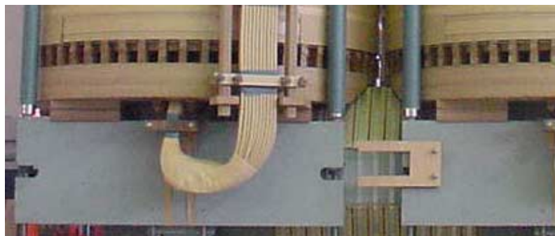
Détail de serrage indépendant de la bobine
