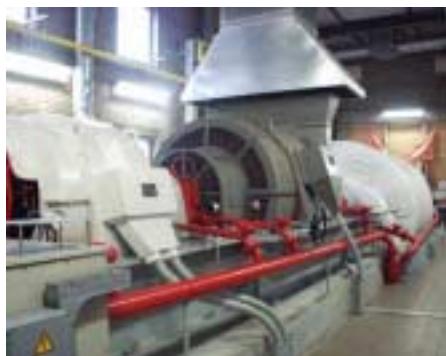
Assemblage d'un générateur
